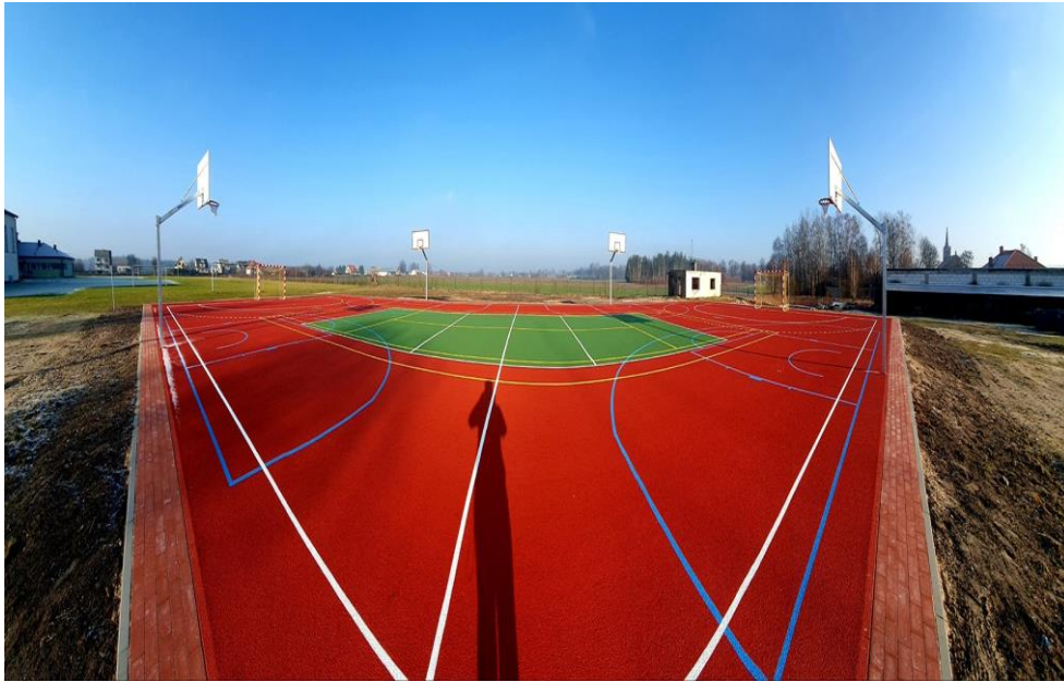
„Budowa boiska wielofunkcyjnego w miejscowości Czerwonka Włociańska”
