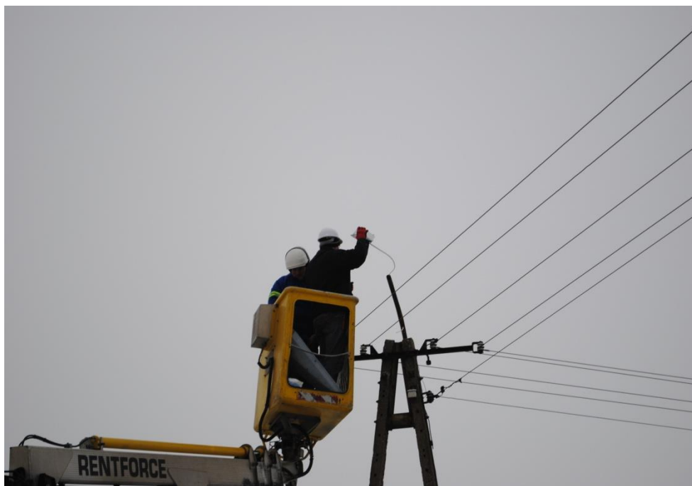
„Modernizacja oświetlenia drogowego w miejscowości Ciemnowo”
